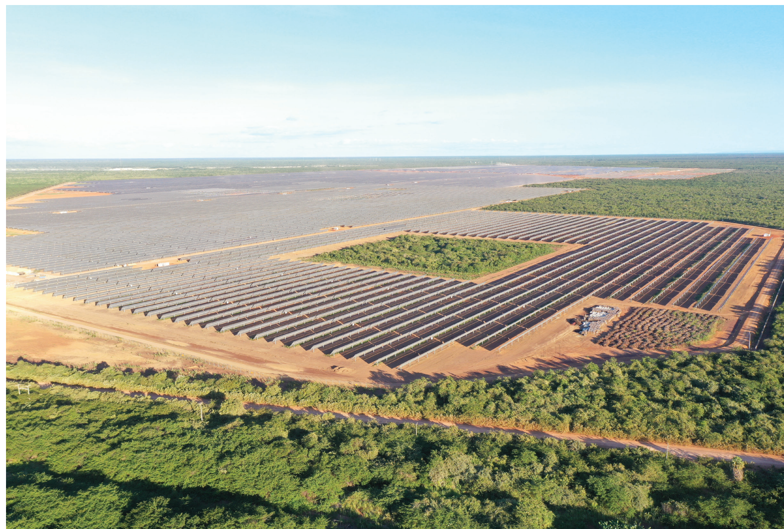
■ Complexo Solar Alex, operado pela Elera no Ceará
